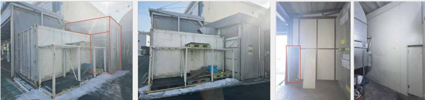
[ 냉동 컨테이너 방음벽 설치 진행과정 ]
