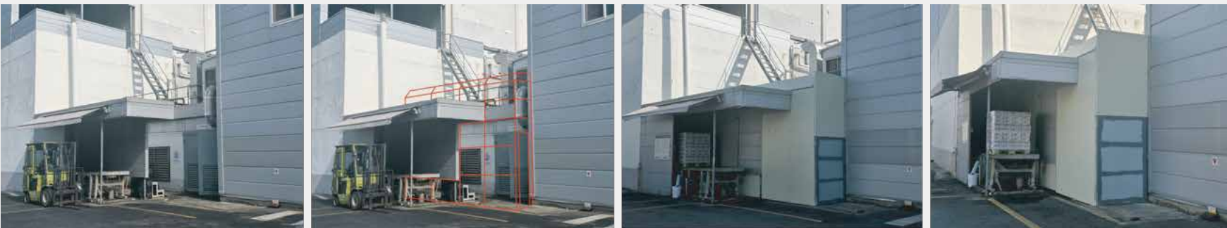
[ 에어컴프레셔실 방음벽 설치 진행과정 ]
